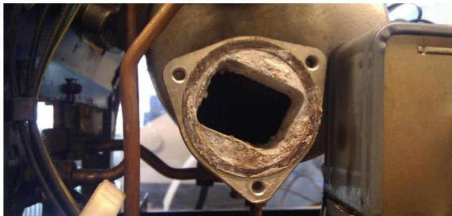
Abbildung 6: Dichtung der Füllstandsanzeige (o.) und verkalkte Dichtung zwischen Kessel und Heizspule (u.)
